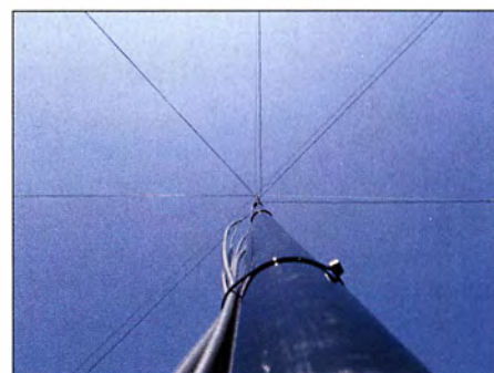
Bild 30: Blick vom Fußpunkt des VDA in Richtung Mastspitze
