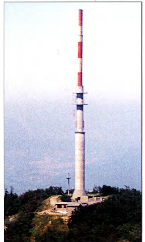
Diese Luftaufnahme aus dem Jahr 1968 zeigt den Sendeturm so, wie er 1964/65 ursprünglich errichtet wurde. Er hatte bis zum Sturmschaden 1974 eine Länge von 83,7 m. Heute ist er zehn Meter kürzer.
