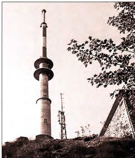
Der neue Stahlbetonturm steht 1965 kurz vor der Fertigstellung. Es fehlen noch die Antennen sowie die Verkleidung des aufgesetzten Stahlträgers.
