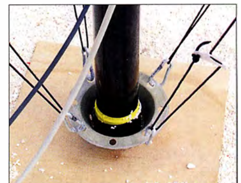
Bild 21: Mastfuß eines VDA für 10 m bis 30 m
