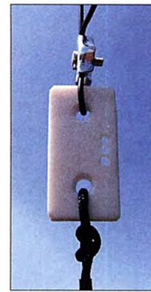
Bild 26: Mittensisolator im Einsatz
